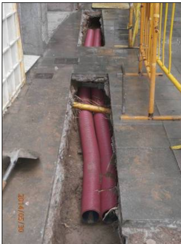
Fotografia 11: Col·locació dels tubulars de plàstic a la rasa de la vorera.
