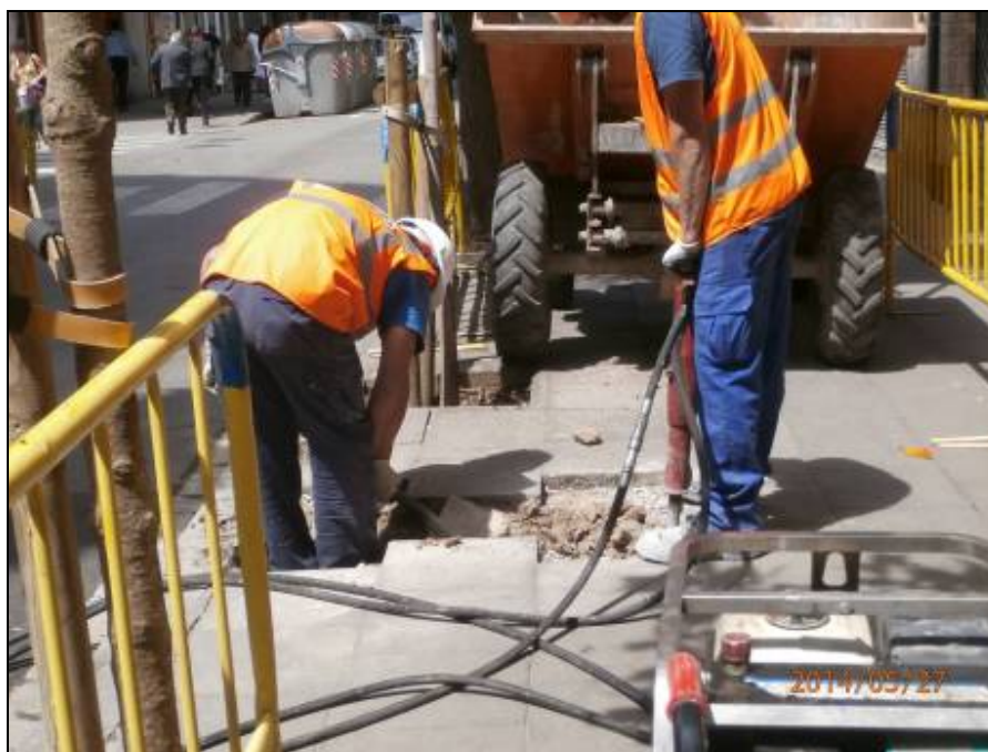
Fotografia 12: Trencament de la vorera per la cala davant del número 31 del carrer de la Riera Alta.
