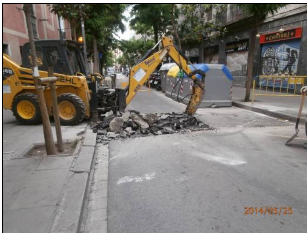
Fotografia 4: Trencament de l'asfalt del carrer de la Riera Alta.
