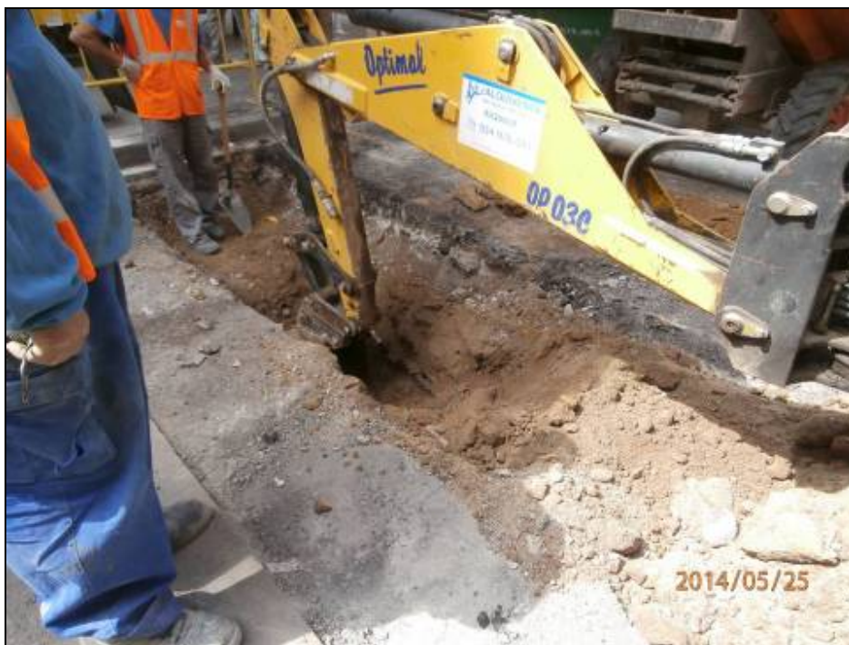
Fotografia 5: Buidament de la rasa de creuament del carrer.
