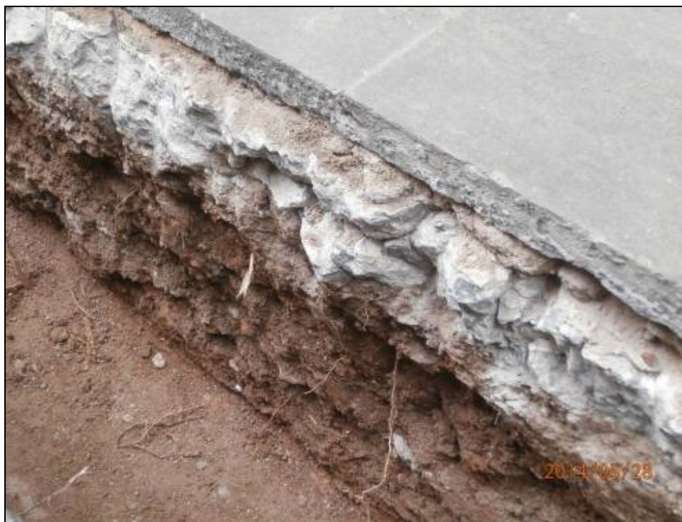
Fotografia 10: Estratigrafia de la rasa.
