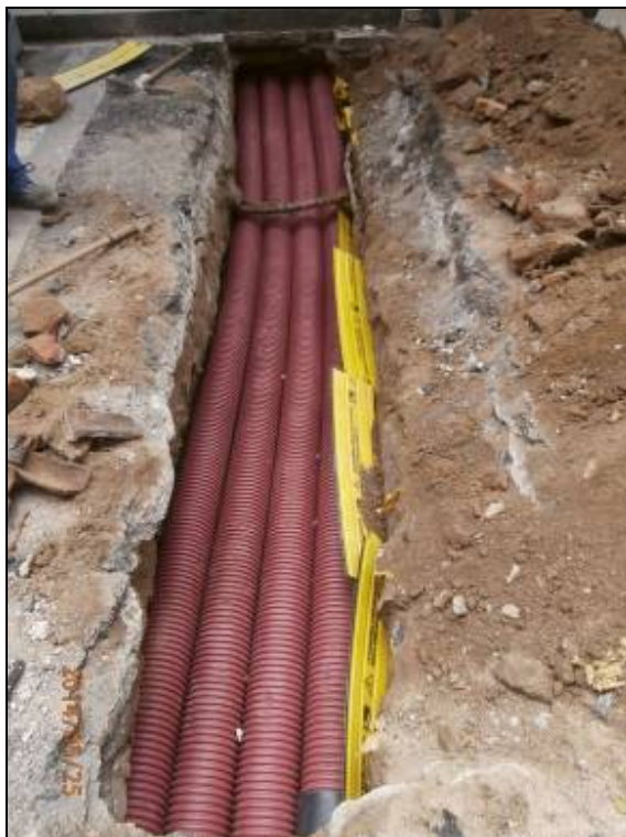
Fotografia 7: Col·locació dels tubulars de plàstic.
