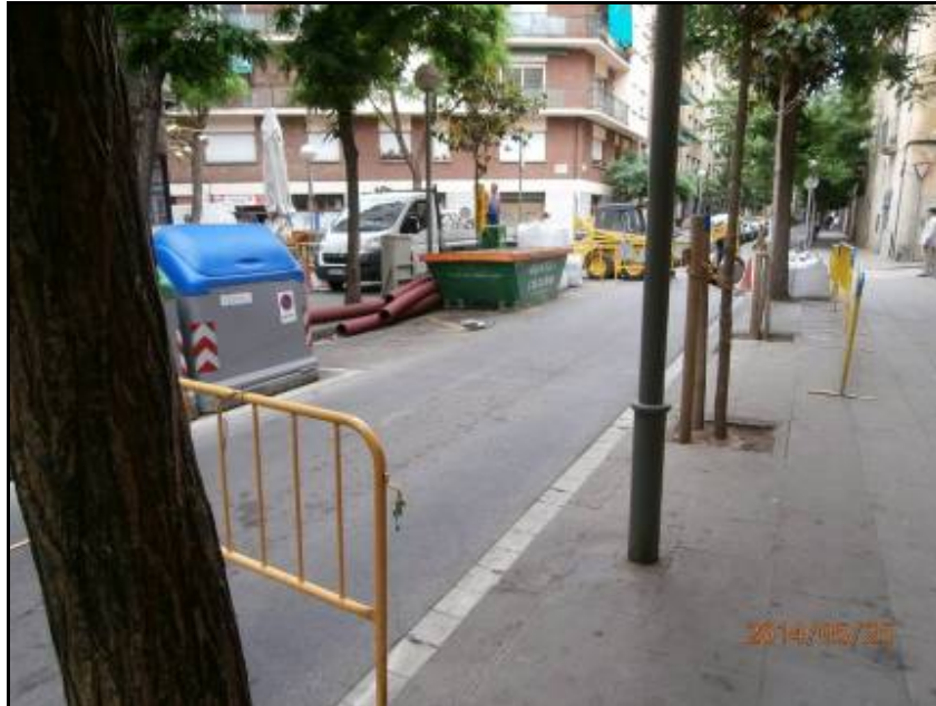
Fotografia 1: Vista general del carrer de la Riera Alta en el seu tram afectat per l'obra.
